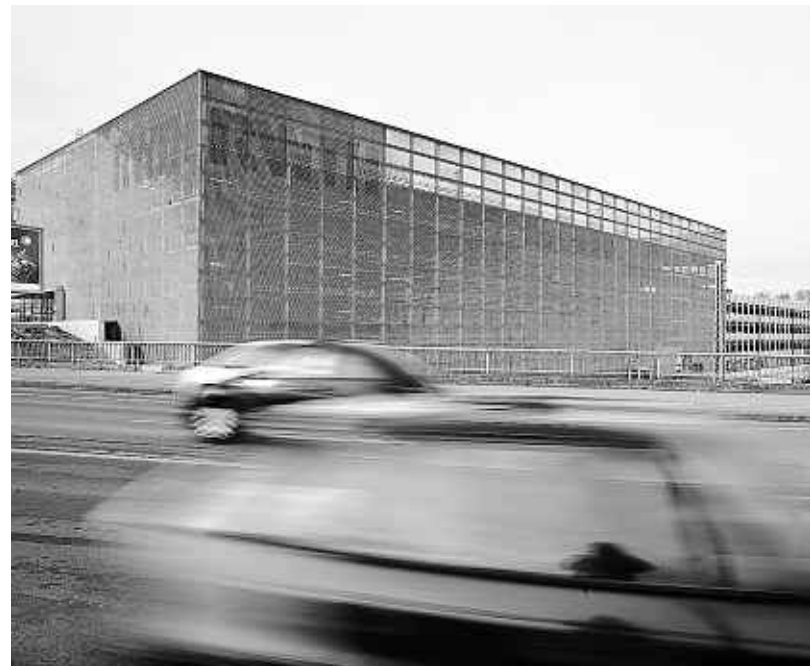
Weithin sichtbar erhebt sich an der Ecke Turmstraße/Professor-Pirlet-Straße das neue Parkhaus der RWTH. Foto: Andreas Herrmann
